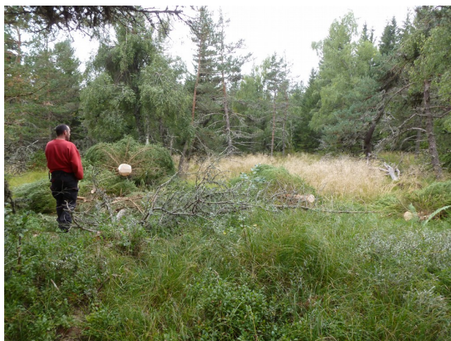
Tourbière de Lou Devez : coupes d'épicéas en cours le 06/09/2019. Des placettes de suivi botaniques ont été mises en place sur le site avant les travaux pour contribuer aux retours d'expériences.
