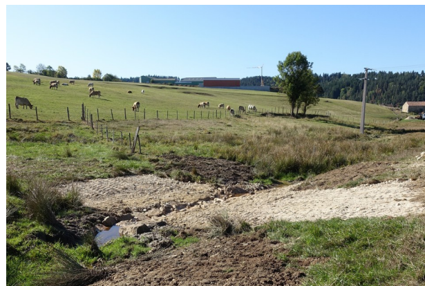
Photos avant et après aménagement d'un passage à gué (automne 2019). Les vaches ont très vite pris l'habitude d'y passer même en l'absence des clôtures pour protéger les berges.
